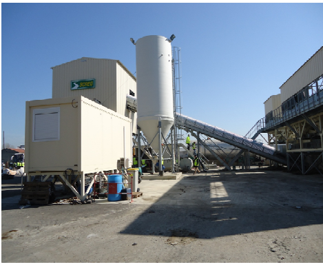
Panorámica de la planta
