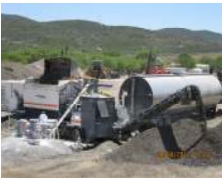
Panorámica de la planta
