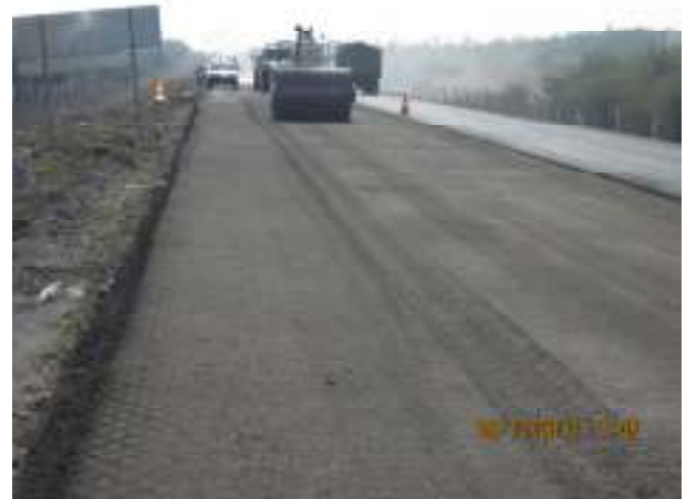
Compactación de la mezcla
