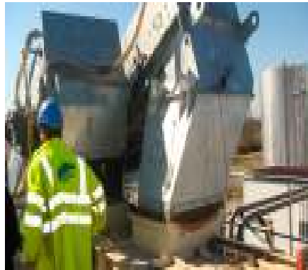
Descarga de materiales al doble mezclador
