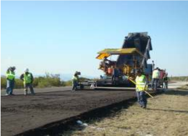
Tendido con pavimentadora
